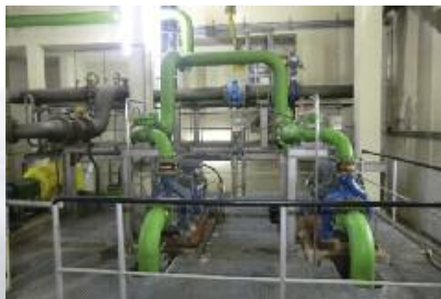
Gemeinsames Entnahmebauwerk von RWE und Emschergenossenschaft am Rhein-Herne-Kanal in Essen
